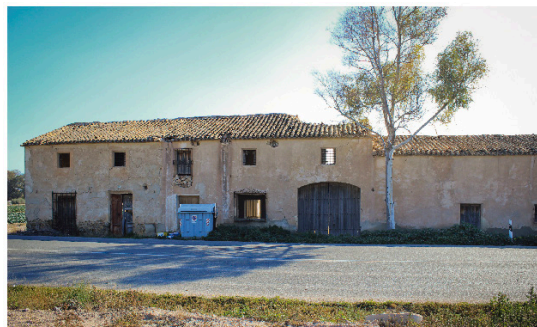
Figura 5. Fachada principal de la Venta del Pintado, con un acceso para carros y otro peatonal.
